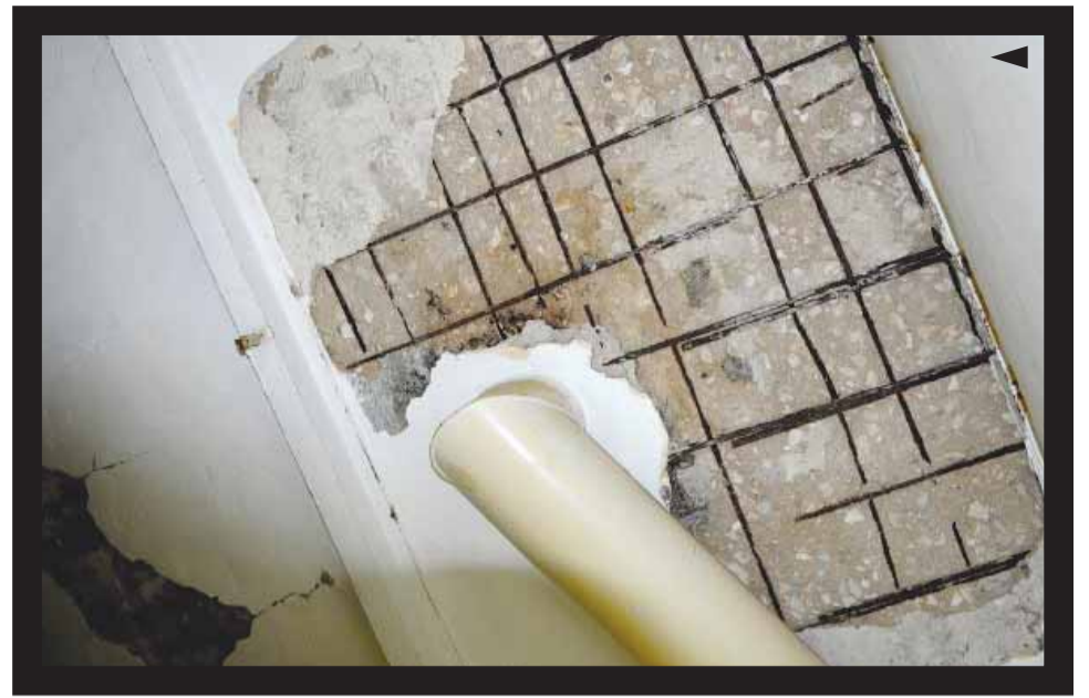
صورة عن جزء من السقف المنهار في مطبخ المنزل.. التَشَقَّقات تبدو واضحة في جزئه الآخر
