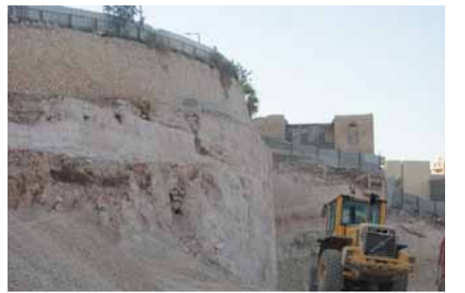
• أعمال حفريات في وادي الصليب
