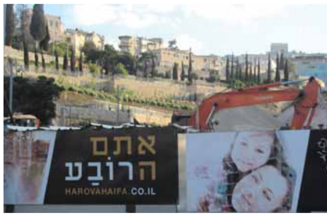
• أعمال حفريات في وادي الصليب
